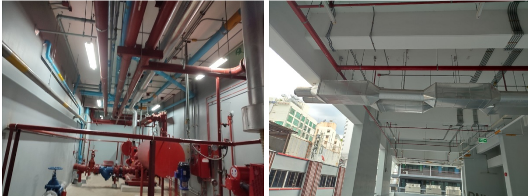
ภาพที่ 2 บริเวณดำเนินการแก้ไขท่อไอเสีย Fire Pump ที่อาคารจอดรถชั้น 8
